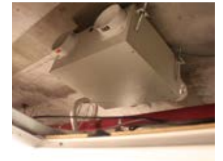
[ 천정 타공 후 매립 설치 ]
