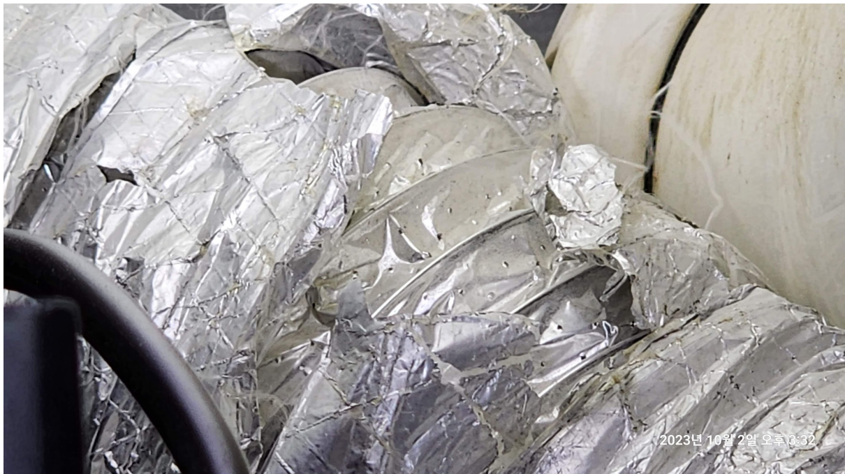
<그림2> 주름관의 외피가 손상되어 내피의 구멍이 노출되었고, 이를 통해서 바람이 주름관 밖으로 나옴이 확인됨(주변 실밥 같은것들이 움직임)
