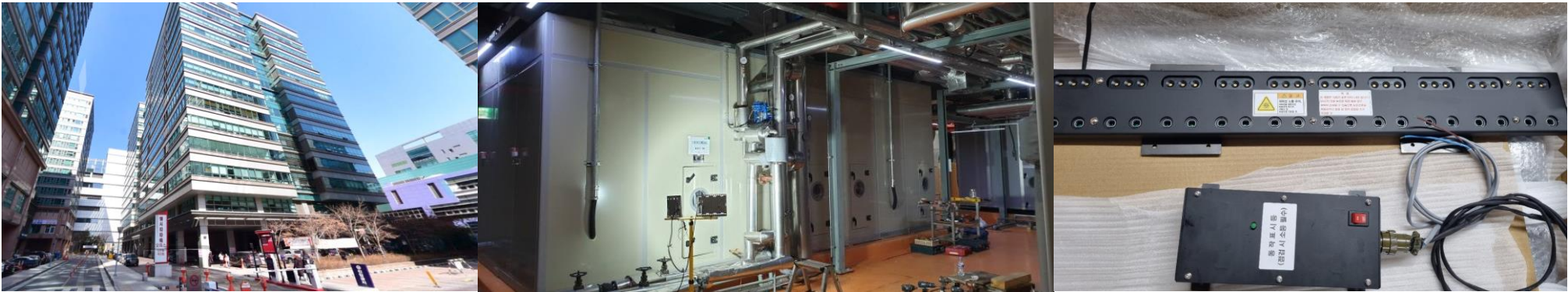
일산 엠씨티타워 (1~14층 전체, 공기기 5대) 공기기내 설치
